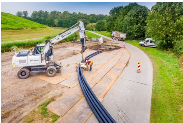
Figuur 22 Impressie boring met uitleg mantelbuizen
