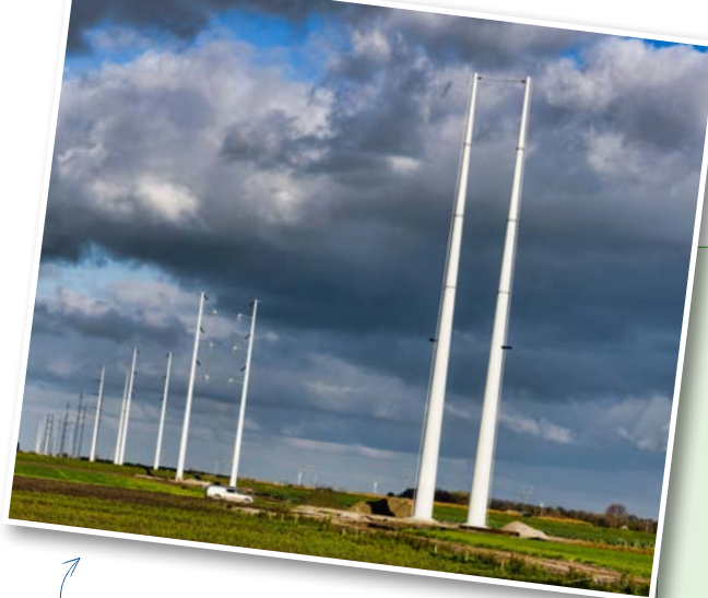
Een wintrackmast in aanbouw
