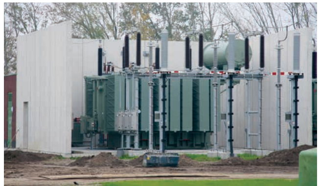
Voorbeeld van een transformator in een U-wand
