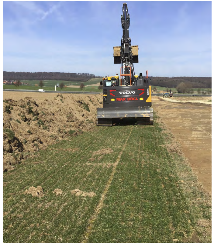
Rückschreitender Oberbodenabtrag
