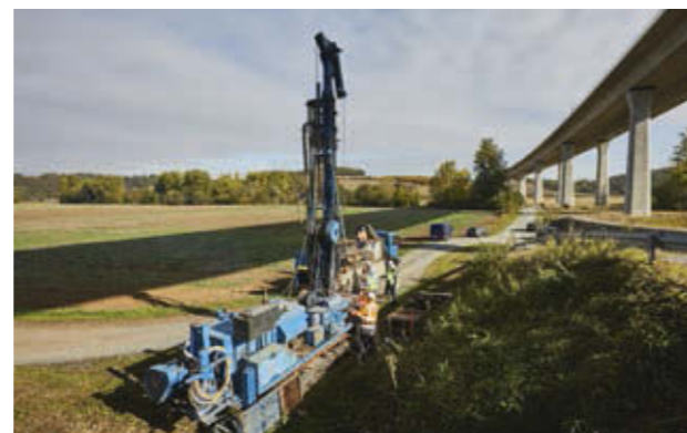
Mit Hilfe einklappbarer Bohrtürme werden Bodenproben aus bis zu 100 Metern Tiefe entnommen.
