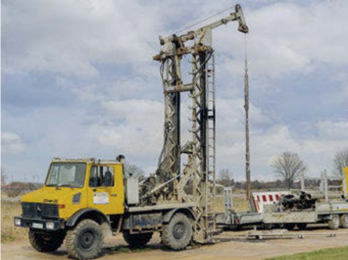
Ein Lkw bringt das Bohrgerät zur Baustelle.
