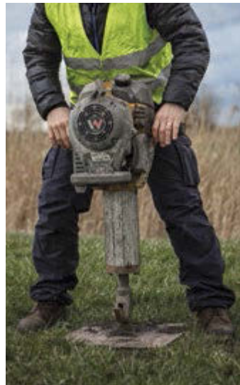
Ein Kleinrammbohrer kommt vor allem bei kleinen Sondierungen entlang der Regelstrecke zum Einsatz: Eine hohle Stahlsonde wird über einen darauf geschraubten Schlagbolzen mit einem Schlaggerät in den Boden gestemmt.
