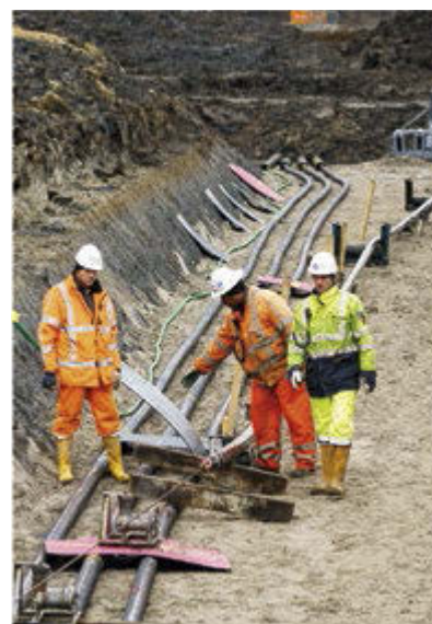
Baubegleitend: Bodenschutz bei der Bauausführung
