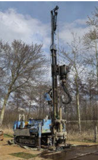
Ein Rotations- oder Rammkernbohrgerät presst das Kernrohr mit einer rotierenden Bohrkronen durch Druck in die Tiefe, um die Bodenproben aufzunehmen.
