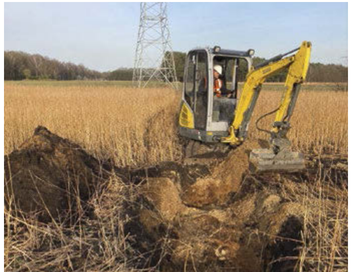
Eine Schürfgrube ist bis zu vier Meter tief. Bodenkundler notieren und beschreiben wichtige Parameter wie Korngröße, Wassergehalt oder organische Bestandteile.
