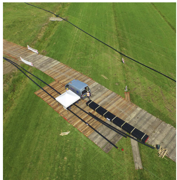
Bodenschutz mit Baggermatten aus Holz.
