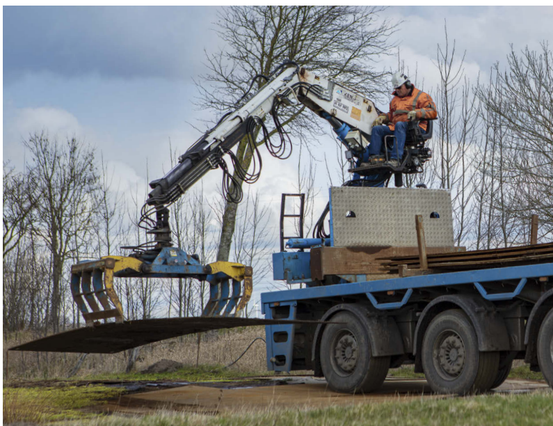
Ein Lkw mit flachem Anhänger legt die Metallplatten aus, um den Boden zu schützen.
