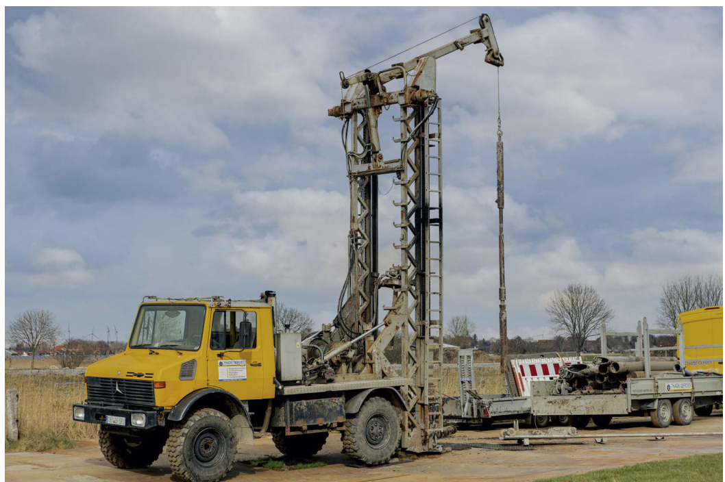
Auf der Baustelle werden üblicherweise das Bohrgerät sowie ein kleiner Transporter oder Anhänger für Material abgestellt.
