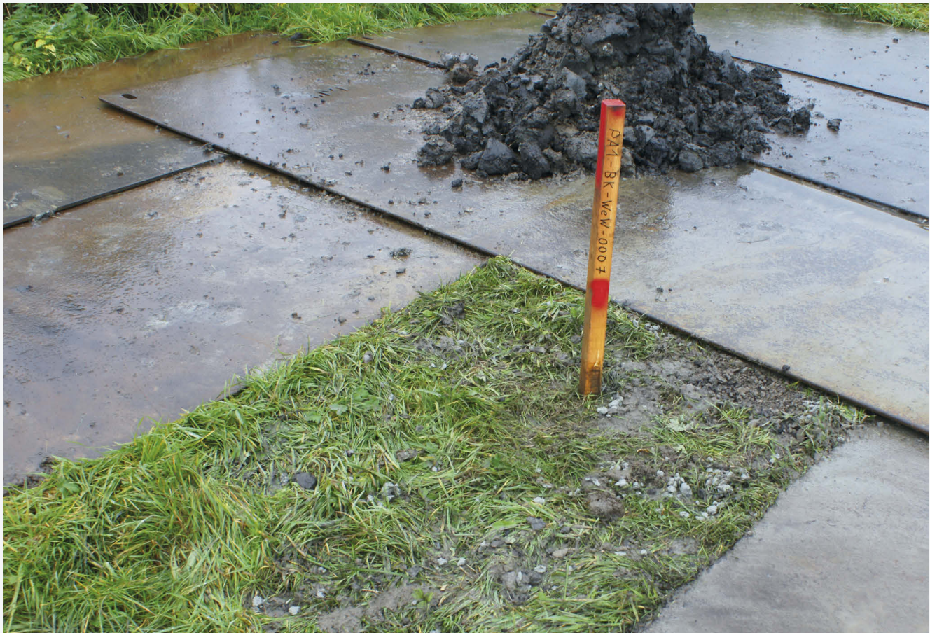
Bei der Beweissicherung ist in der Regel ein Vermesser dabei, der mittels GPS die geplanten Bohrpunkte mit Pflöcken absteckt.
