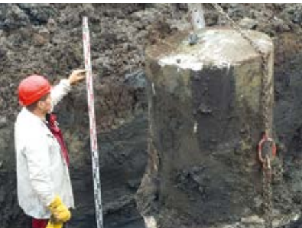
Entfernung der Mastfundamente
