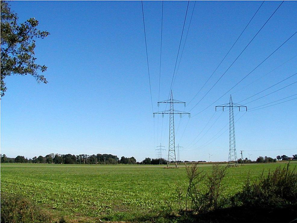
**Abb. 4:** Vorhandene 110-kV-Freileitung und 110-kV-Bahnstromleitung südlich Dreeke (Foto: Planungsgruppe Landespflege)
