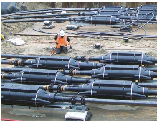
Muffengruben im Bau
