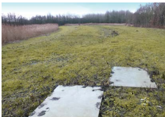
Cross-Bonding-Kästen in der Betriebsphase
