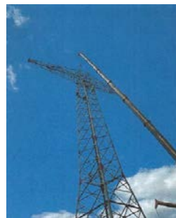
Afbeelding 1: Werkzaamheden op hoogte aan de mast
