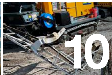
Opnieuw arbeidsongeval bij funderingswerkzaamheden Lees meer
