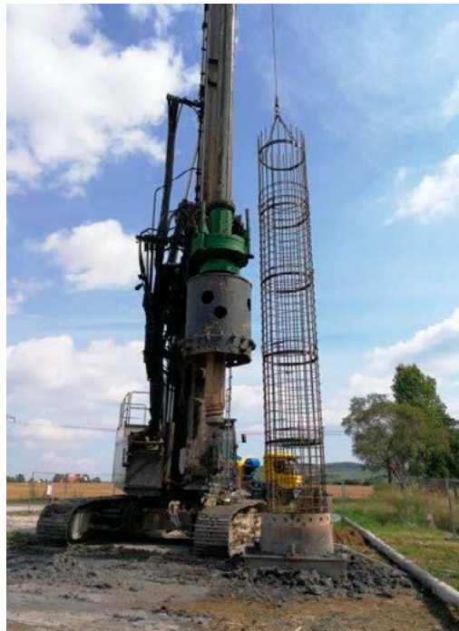
Beispielfotos Bewehrungskorb/Bohrsituation
