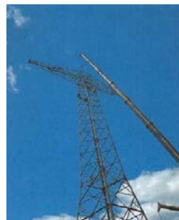
Abbildung 1: Höhenarbeiten am Mast
