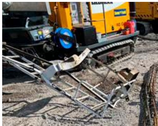
Beschädigter Bagger und Bewehrungskorb
