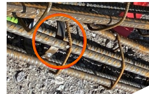
2: Wapeningskorf met de afgescheurde lasnaad van de als bevestigingspunt gebruikte ring.
