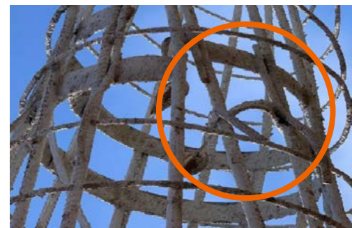
1: Wapeningskorf met gescheurde platte stalen ring die als bevestigingspunt werd gebruikt.
