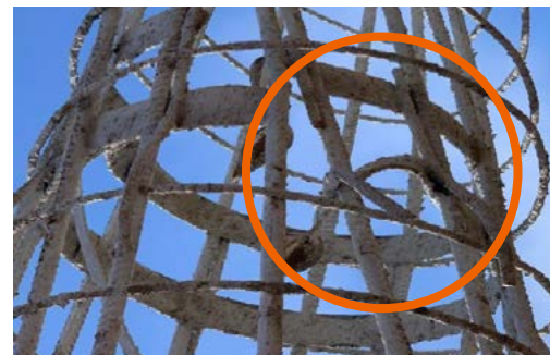
1: Bewehrungskorb mit gerissenem Flachstahl (Anschlagpunkt)
