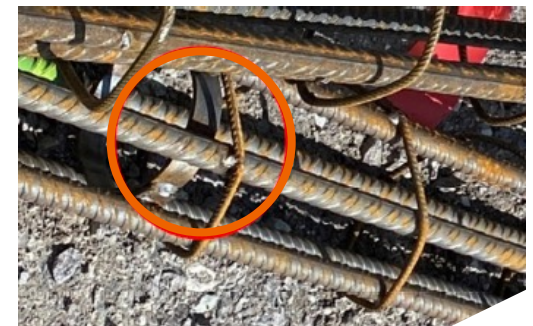
2: Bewehrungskorb mit gerissener Schweißnaht am Flacheisen (Anschlagpunkt)
