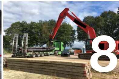
Tödlicher Unfall beim Verladen von Kabelleerrohren
