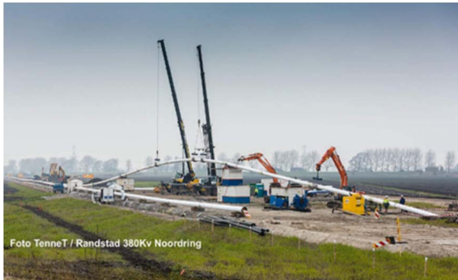
Figuur 16: Boring Randstad 380 kV
