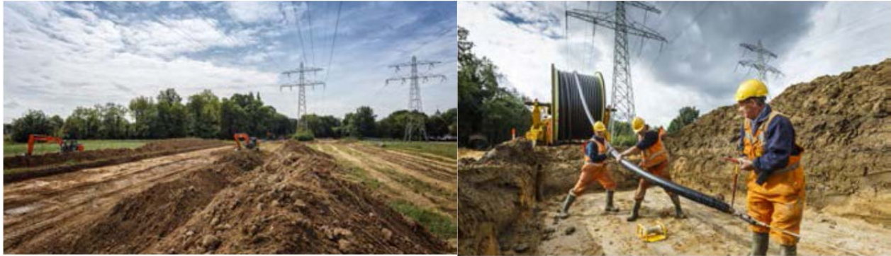
Foto 19: Open ontgraving, sleuven graven en kabels trekken.
