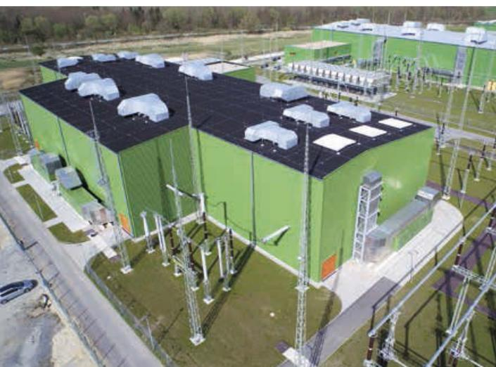
Konverter an Land stellen mit dem dazugehörigen Umspannwerk den Knotenpunkt für die Einspeisung des Seestroms ins Netz dar.
