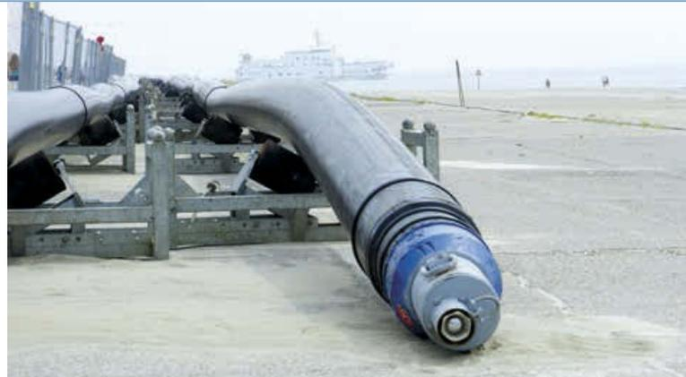
Horizontalbohrungen: In die Kunststoffrohre werden später die eigentlichen Kabel eingezogen.
