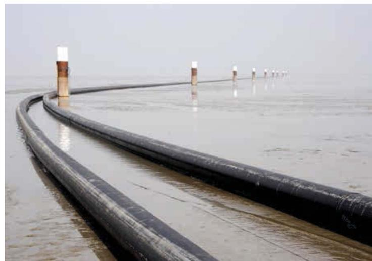
*Deiche, Dünen und Watt werden unterbohrt. Die Kunststoffrohre werden in die Bohrungen eingezogen, später die Kabel eingeführt.*
