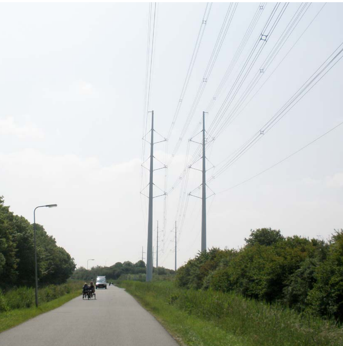
Figuur 36. Afwijking in richting. Door strakke bundeling met snelweg zijn kleine knikken ontstaan die het beeld rommelig maken
