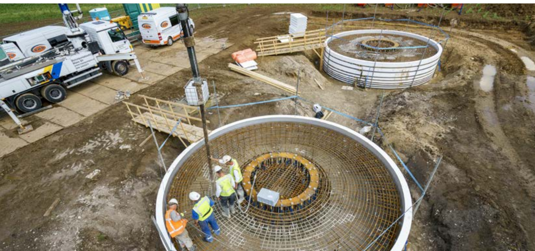
Figuur 70c. Werkterrein met fundering mastvoeten
