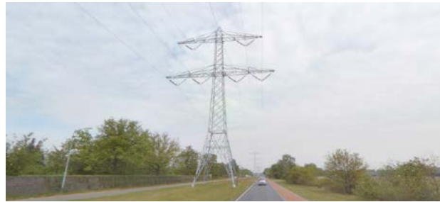
Figuur 24. 150 kV in Uden Industrielaan. Strakke bundeling met volledige overlap. In de oostelijke stadsrand van Uden staat de 150 kV-verbinding Uden - Aarle-Rixtel in middenberm van de Industrielaan. De zro-zone van de lijn overlapt 100% met de gebruiksruimte van de weg
