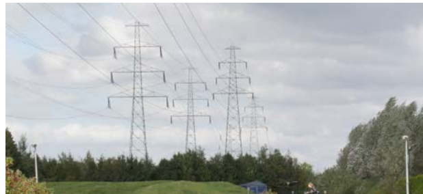
Figuur 26. 2 x 150 kV in Assen-West. Bundeling met volledige overlap. De twee 150 kV-verbindingen Beilen-Marsdijk en Beilen Zeyerveen staan op een afstand van slechts 20 m hart op hart van elkaar. De stad is onder de lijn door gegroeid, de bundel is in een informele parkzone is opgenomen
