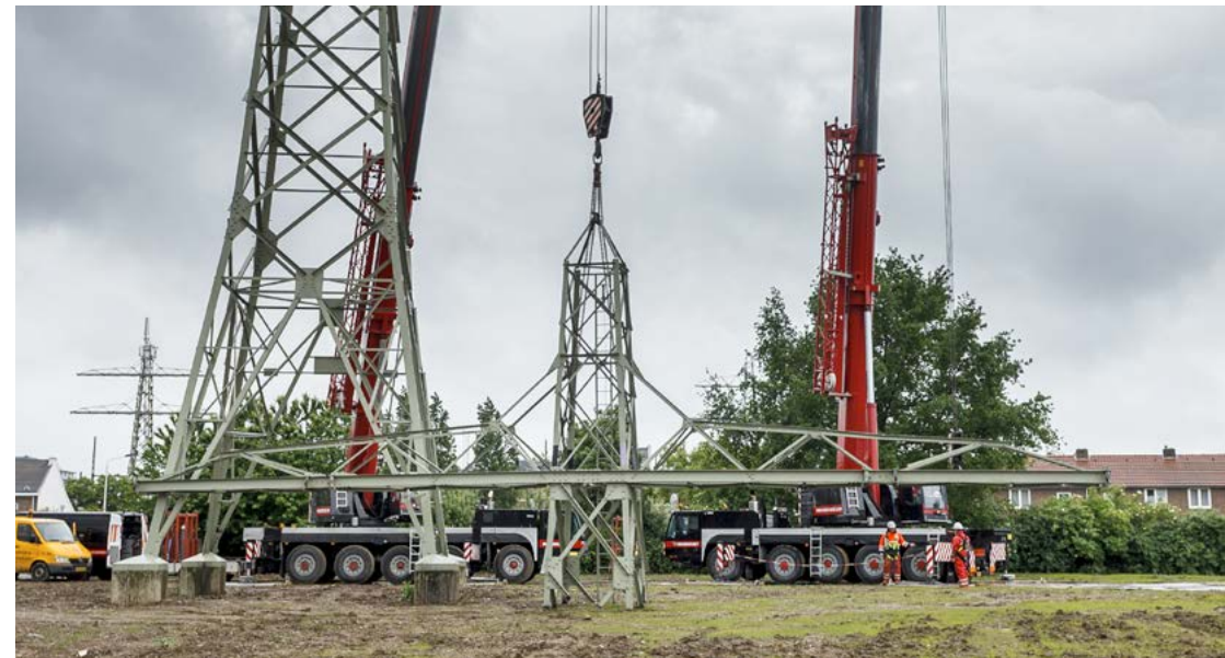
Figuur 70g. Amoveren 150 kV-vakwerkmast
