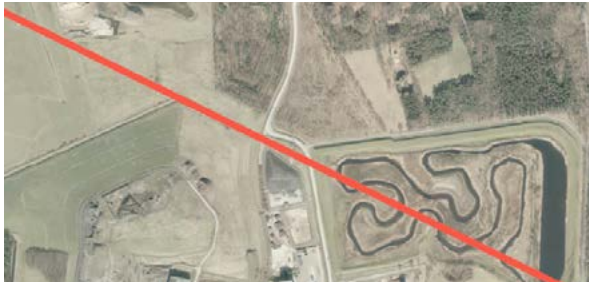
Figuur 45. Station Tilburg, gepland als onderdeel van het project Zuidwest380kV. Er moet een schakel tot stand komen tussen de bestaande 380 kV verbinding Geertruidenberg- Eindhoven, een nieuwe 380 kV-verbinding Rilland-Tilburg. Voor oriëntatie van het station zijn drie varianten ontwikkeld. De derde variant levert de meest eenvoudige constellatie van masten, jukken, geleiders en kabels op en heeft daarom de voorkeur
