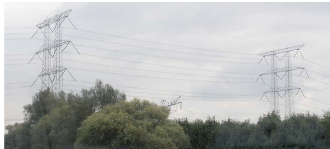
Figuur 38. Afwijkingen in veldlengte. Zeer korte veldlengte om de geleiders hoog te houden
