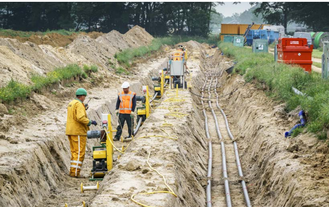
Figuur 70h. 150 kV-kabelbed
