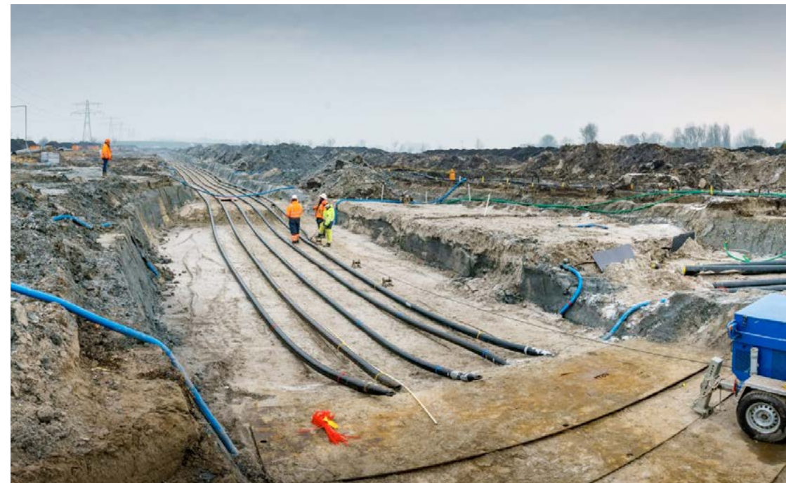
Figuur 70i. 380 kV-kabelbed open ontgraving
