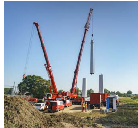
Figuur 70e. Plaasten van delen van Wintrackmasten
