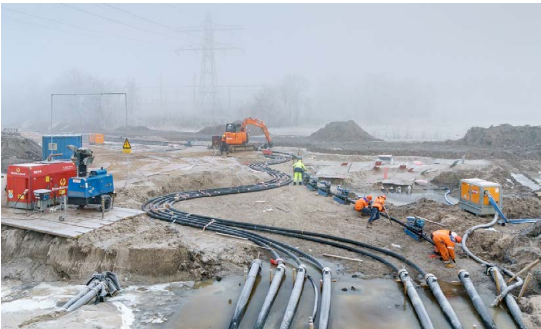
Figuur 70j. 380 kV-kabeluitleg tbv boring
