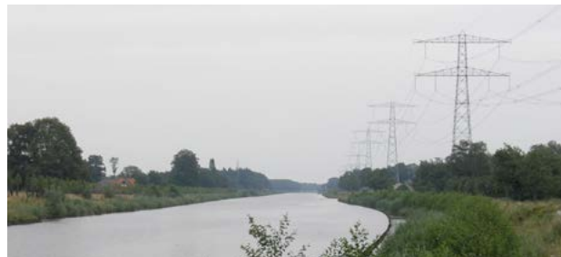
Figuur 27. 380 kV bij Goor Zone-bundeling. De 380 kV-verbinding Doetinchem-Hengelo is over grote lengte gebundeld met Twentekanaal. Soms heel dichtbij, soms op honderden meters. Langs kanaal staat op een aantal plaatsen begeleidende beplanting waardoor er plaatselijk een herkenbare ruimtelijke samenhang is ontstaan
