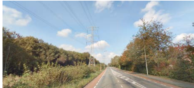
Figuur 25. 150 kV in Heerlen Melcherstraat. Strakke bundeling met gedeeltelijke overlap. De 150 kV-verbinding Huskensweg-Terwinselen staat in de berm van deze stadsautoweg
