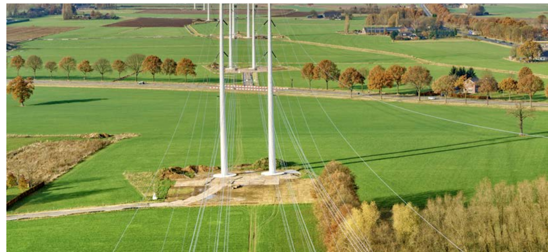
Figuur 70d. Verbinding in aanbouw met werkterreinen
