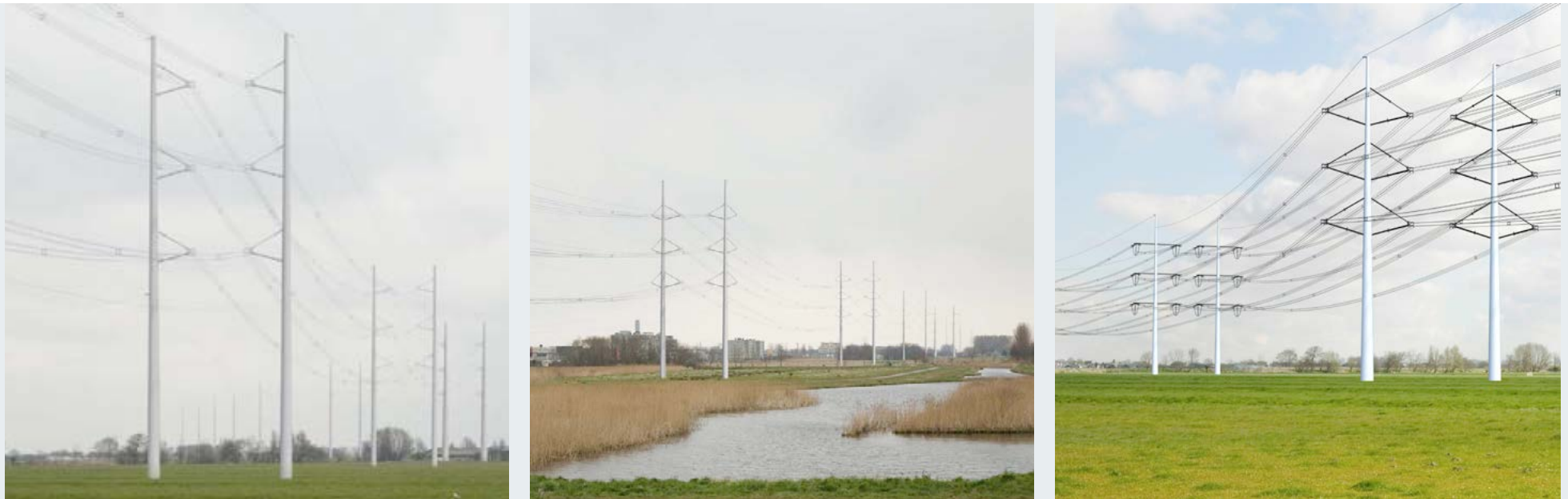
Figuur 13. Fotomontages van hoogspanningslijnen uitgevoerd in Wintrackmasten vlnr: 2 x 380 kV, 2 x 380 kV + 2 x 150 kV, 4 x 380 kV
