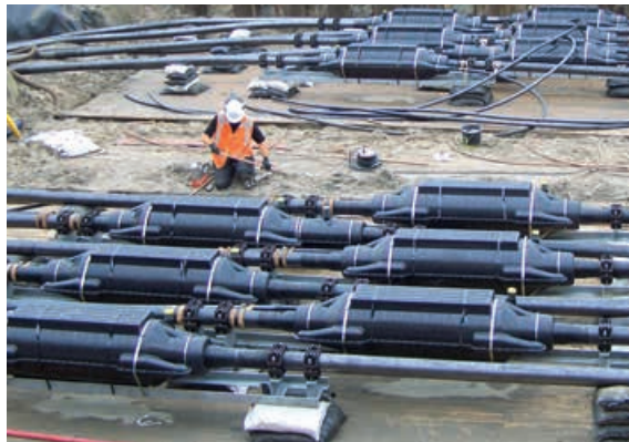
Muffengruben im Bau
