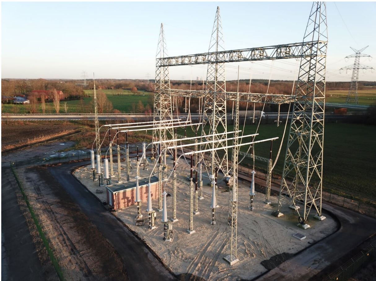
Abbildung 12: Kabelübergabestation Segberg an der A31 Erdkabel verlaufen unterirdisch von links in die Anlage. Auf der rechten Seite wird die Leitung als Freileitung fortgeführt.
