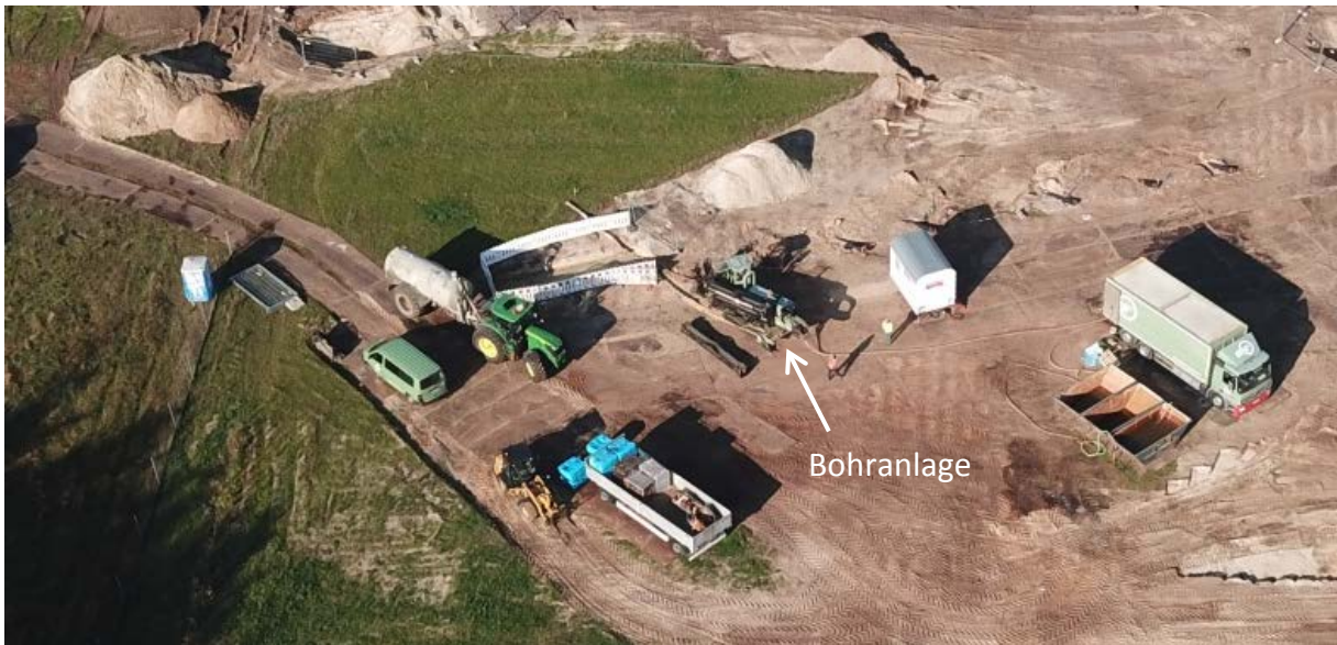
Abbildung 9: Baustelleneinrichtung Spülbohrverfahren HDD
