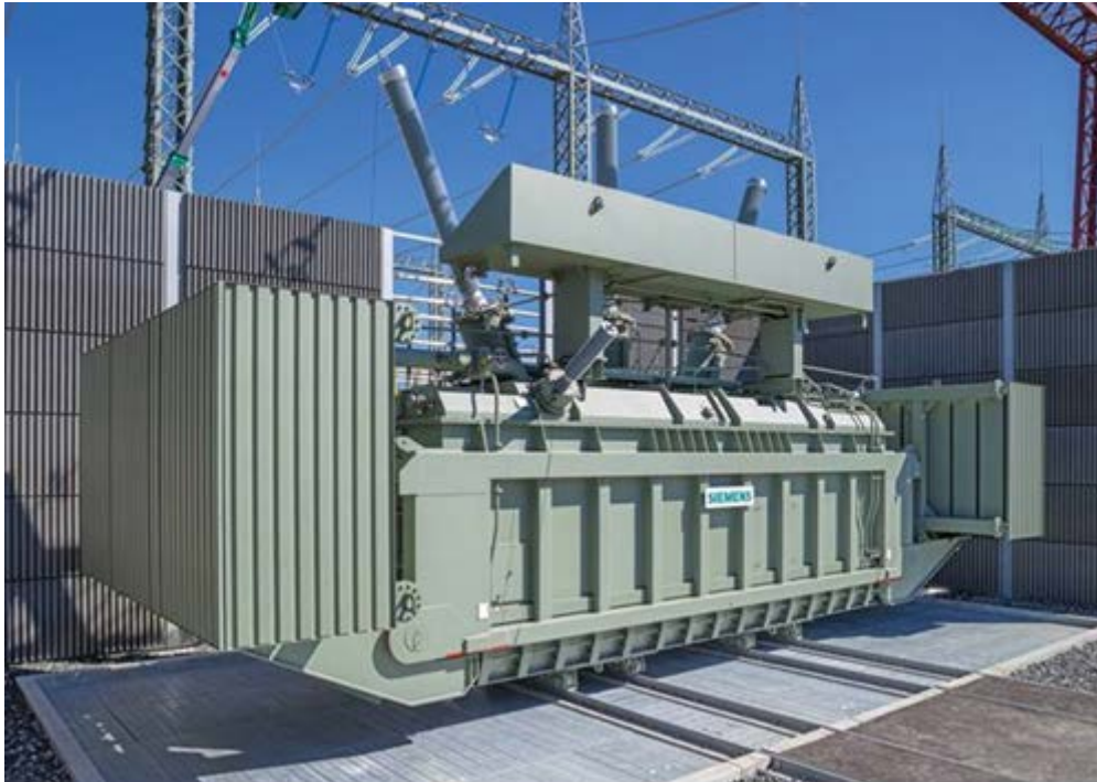
Abbildung 15: 250-MVar-Drosselspule für die Blindleistungskompensation (Quelle: Siemens)
