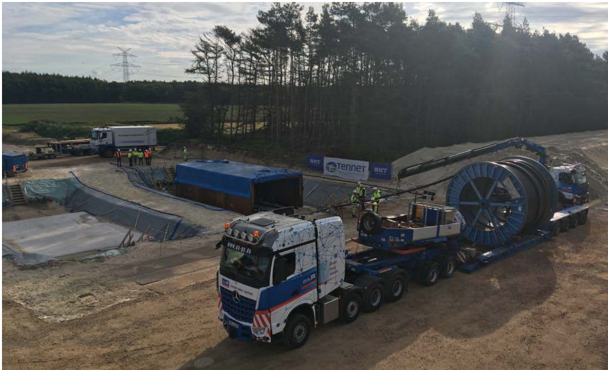
Abbildung 7: Erdkabeleinzug vom Tieflader an einer Muffengrube
