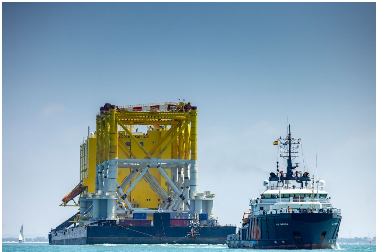
(Bild 20220805_TenneT_DolWin-kappa_Sailout_Low-Res_01-04: Sail-Out der Offshore-Konverterplattform DolWin kappa; Bildnachweis: © TenneT)
